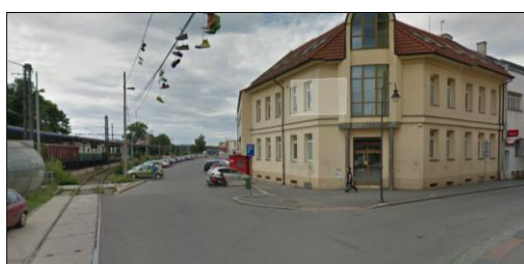
Ul. Porážková – stav před realizací
