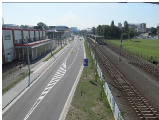
Ul. Porážková po rekonstrukci
