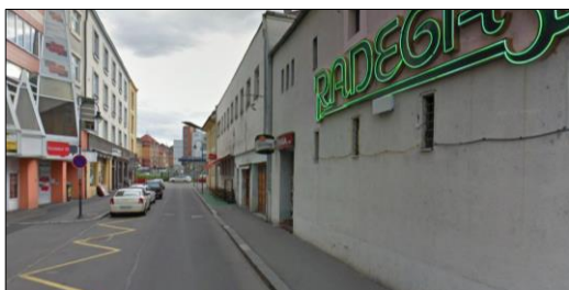
Ul. Stodolní – stav před realizací
