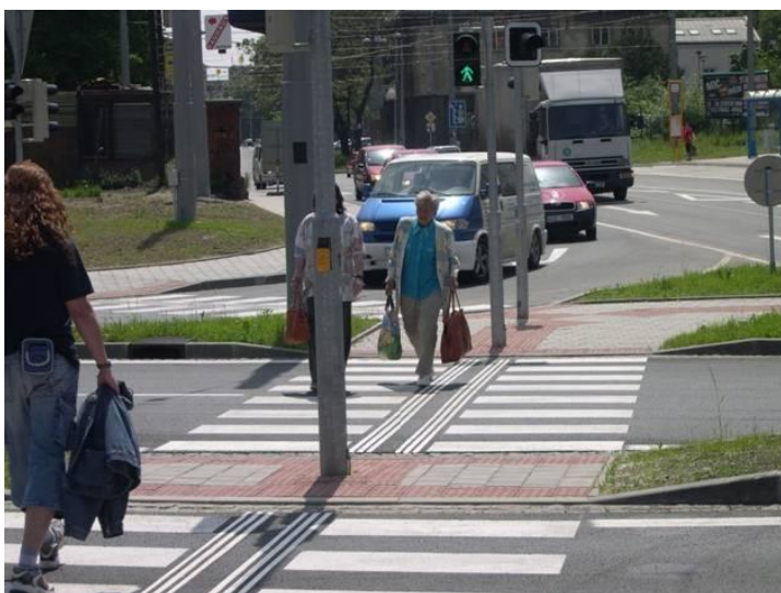
Křižovatka Českobratrská x Hornopolní – úpravy pro tělesně postižené, akustická signalizace pro nevidomé a slabozraké
