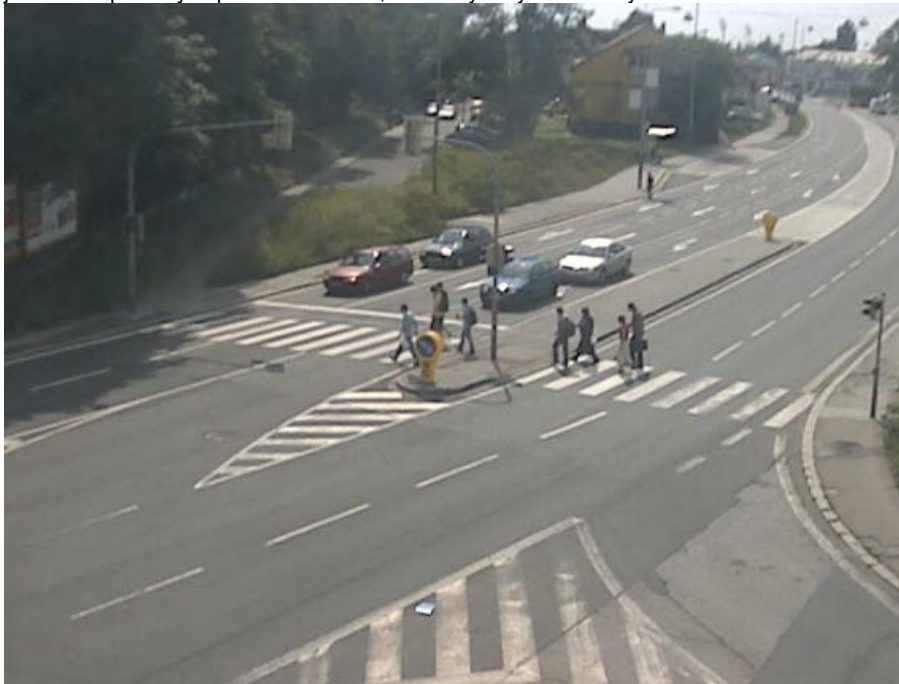
Rekonstrukce křižovatky Rudná x Místecká – nový fyzický ostrůvek na přechodu přes ul. Rudnou od Poruby
