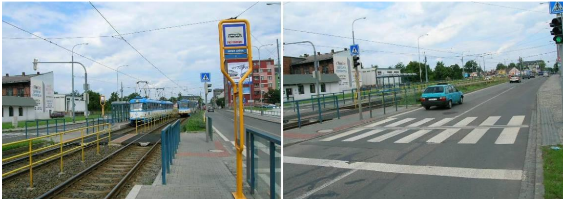
Přechod Ruská – ČEZ Aréna s nesignalizovaným tramvajovým tělesem
