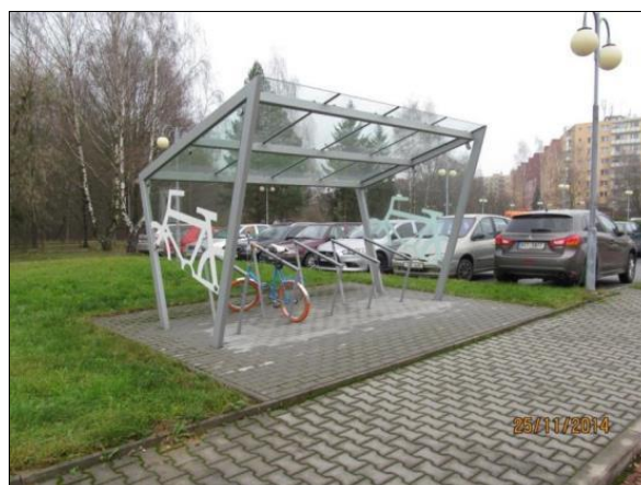
Přístřešek VŠB-TU Ostrava, Fak. stavební
