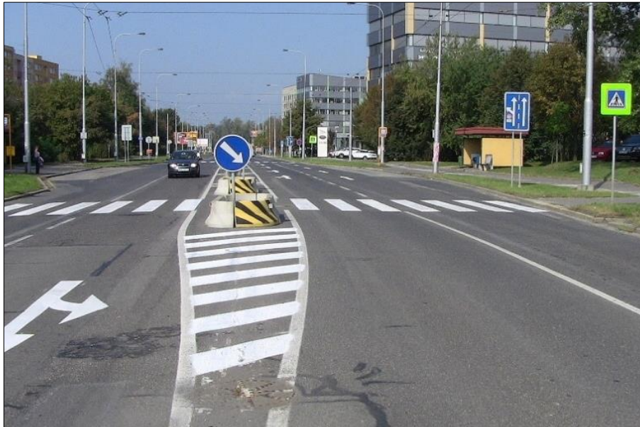
Obr. 2 – Původní ostrůvky z betonové stavebnice City Bloc šířky 1,5 m
