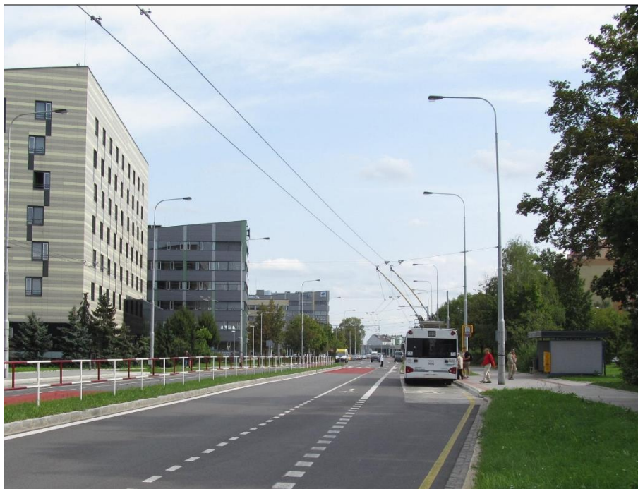
Obr. 3 – Rekonstruovaný úsek se zálivem pro vozidla MHD
