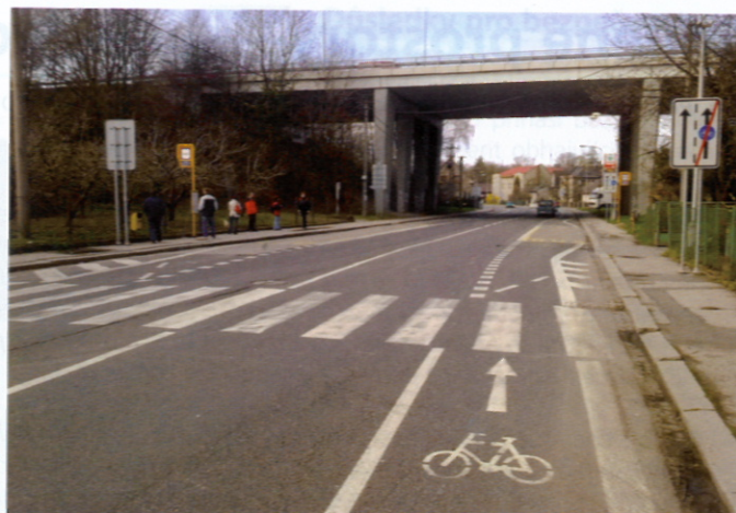
Obrázek 3: Vyhrazený jízdní pruh v ulici Polanecká, Ostrava
