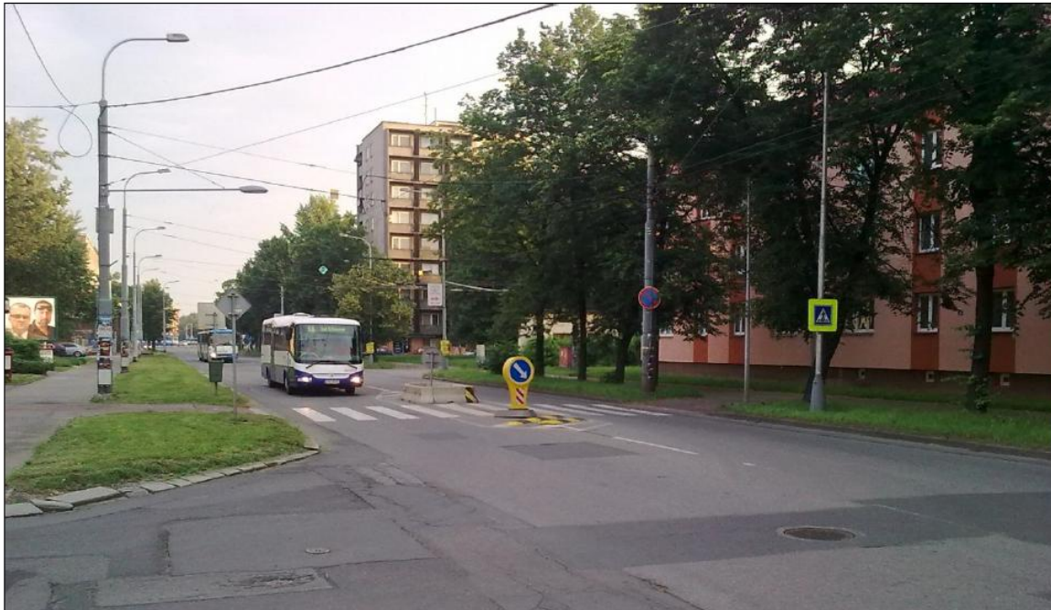
Obr. 1 Řešení dělicího ochranného ostrůvku přechodu pro chodce. Honor byl užit z důvodu odbočování rozměrných vozidel vpravo z hlavní pozemní komunikace. Instalace CITY BLOKU v místě HONORU by omezila vpravo odbočující autobusy, docházelo by ke kontaktu levé zadní části karoserie s ostrůvkem. Spolu s HONOREM byly užity i krátké příčné prahy pro zlepšení krytí přechodu.
