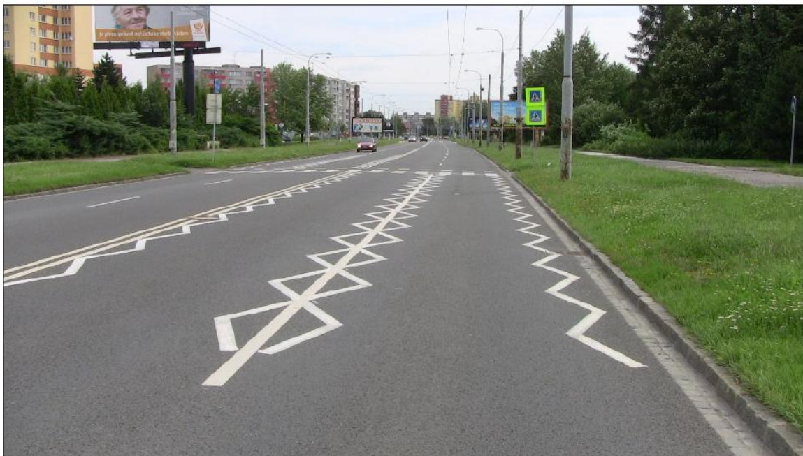
Obr. 2 Zvýraznění přechodu pro chodce na ul. Varenská užitím VDZ V12e
