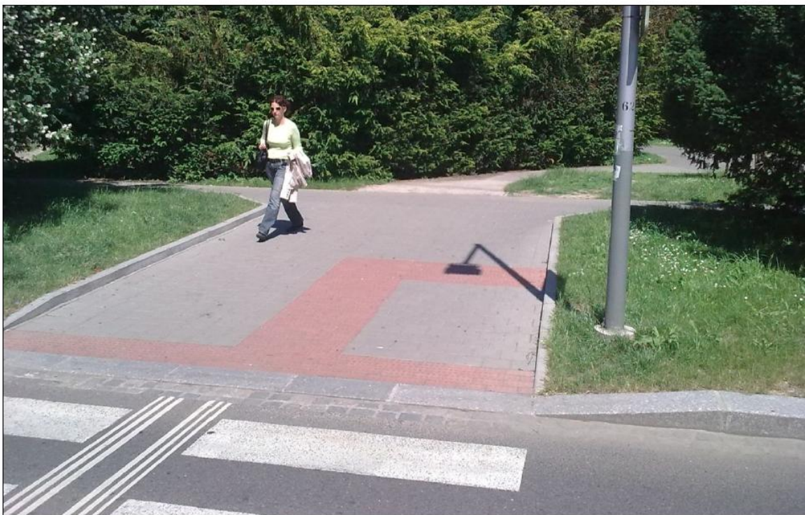
Obr. 9 Nevhodný způsob provedení signálního pásu pro nevidomé. Zástupce TYFLOCENTRA doporučuje protažení signálního pásu až k protější straně vodící linie průběžného chodníku
