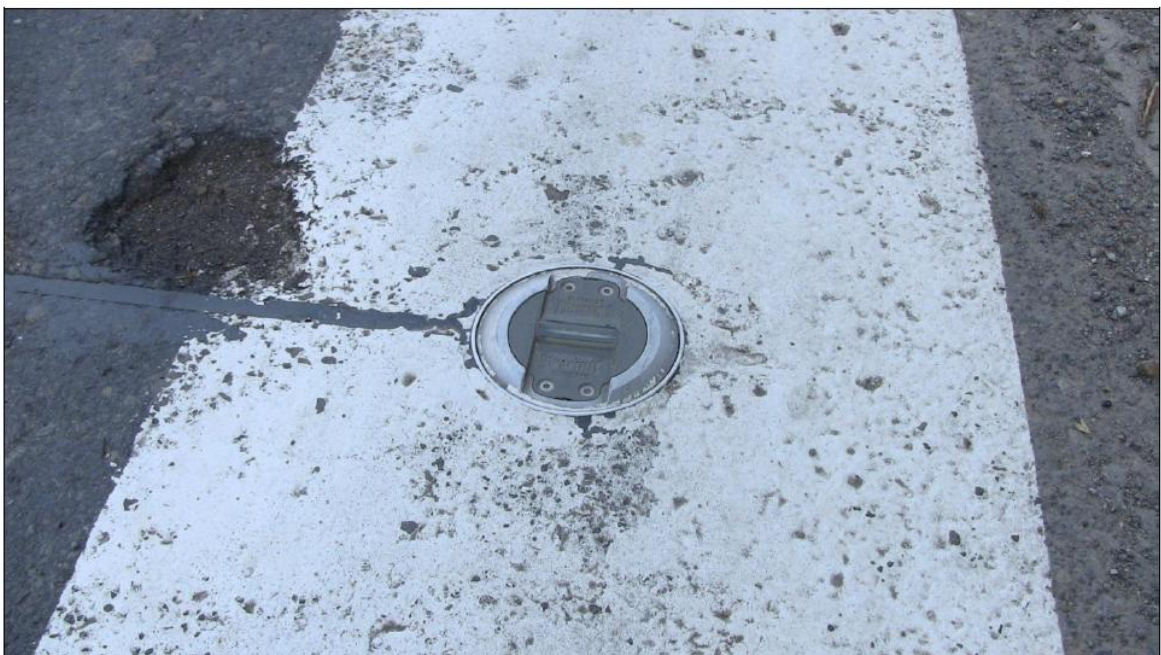
Obr. 6 Zvýrazňující LED svítidlo typ SWAREFLEX LEVELITE 8200
