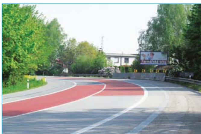
Úprava nehodové lokality zvýšením adheze, sil. I/58 Plzeňská
