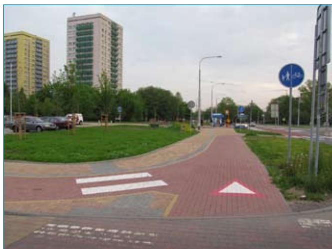
Sídliště Fifejdy - rekonstruovaný úsek trasy F
