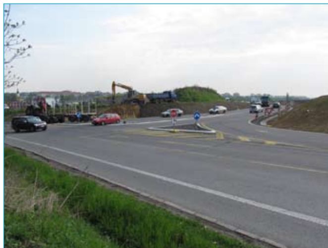
Nová rampa sil. I/II Rudná
