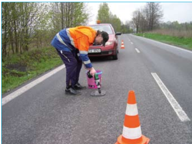
Instalace sčítacího zařízení NC 200
